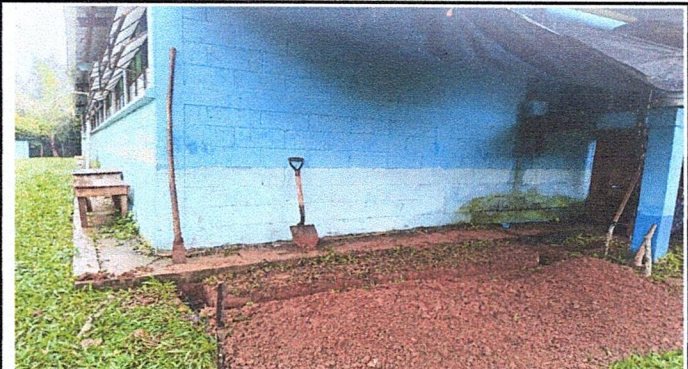
Foto 4: trabajo durante el mantenimiento letrinas para los niños y docentes en la escuela.
